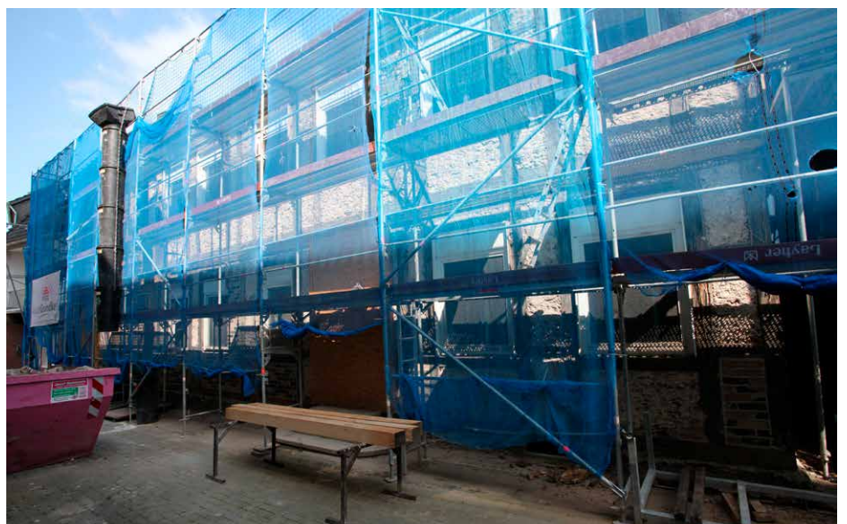
▲ Die Frontseite des Gebäudes zeigt einen sehr guten Baufortschritt.
